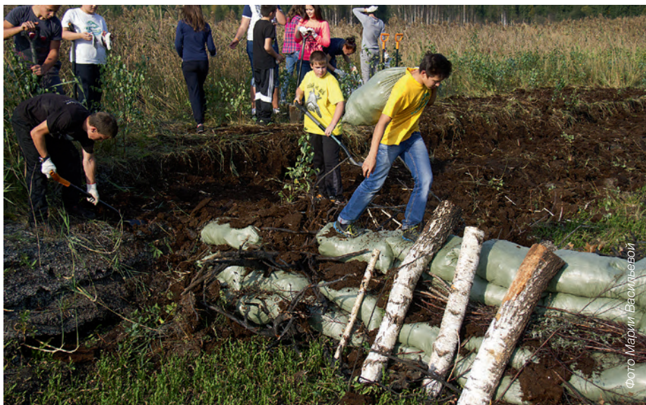
Рис. 29. Создание временной земляной плотины для удержания воды вблизи действующих торфяных очагов силами школьников. Материал — торф в мешках, брёвна. Тверская область
