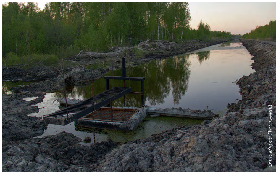
Рис. 27. Обводнение с использованием специальных гидротехнических сооружений. Пример не самого удачного обводнения. Новые дороги и каналы сделали территорию более доступной, но не полностью залитой, то есть увеличилась вероятность возгораний по краям каналов. На фото видно, что весной данное сооружение размывает (не рассчитан перелив). Во многих каналах вода, наоборот, не удерживается без принудительного закачивания насосами. Московская область
